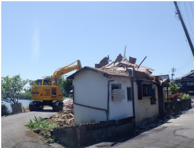
解体中の被災家屋(大川町地内)
