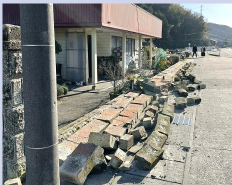
ブロック塀倒壊 (宇土野町)
