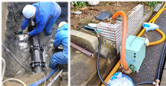
水道の復旧作業
