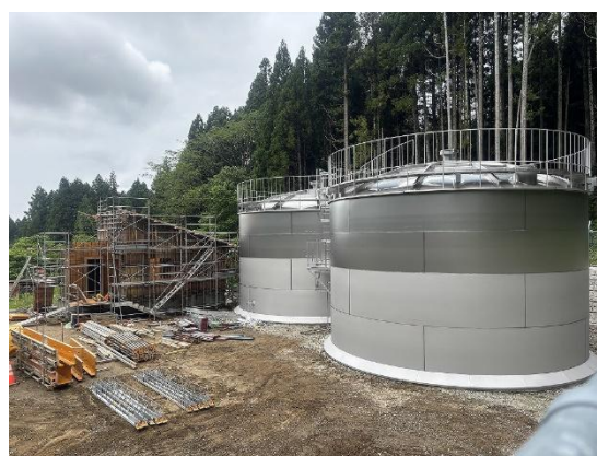
配水池更新工事（東部配水池）
