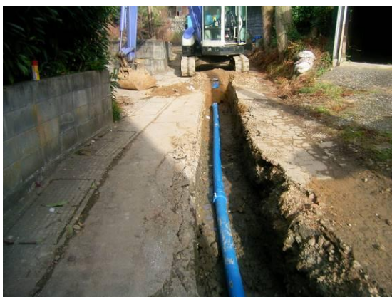
老朽管更新工事
