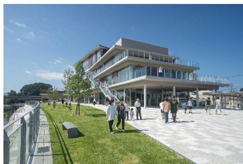
にぎわい交流拠点 LAKUNA はくい
