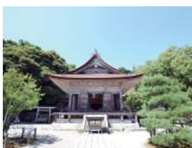
平成の保存修理工事を終えた 気多神社拝殿（国重文）
