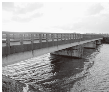
補修工事を行う釜屋大橋
