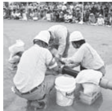
水道管破裂復旧訓練
