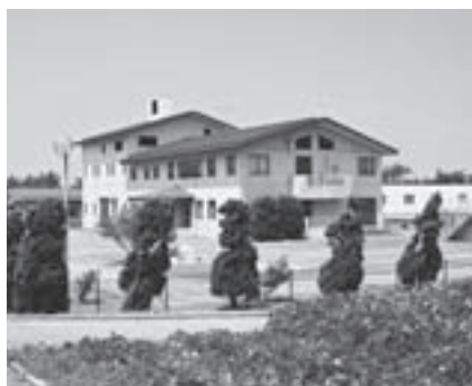
▲羽咋浄化センター（大川町）
