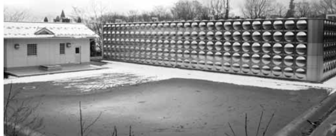
▲新しく出来た北部配水池(右:貯水タンク、左:管理棟)
