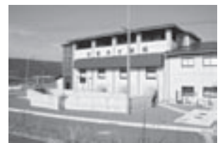
▲余喜排水機場
