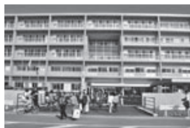
▲完成した藤岡中央高校の新校舎
