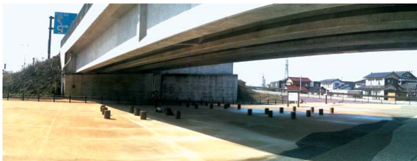
高架下に掘立柱建物跡の位置を 復元表示 (津幡町加茂遺跡)
