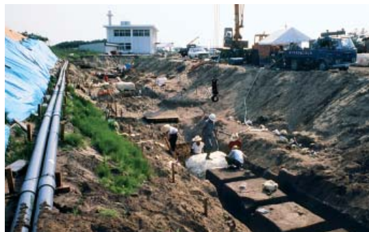
土層ブロックの一時取り上げ工事
