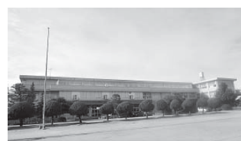
冷房設備の設置を待つ小学校
