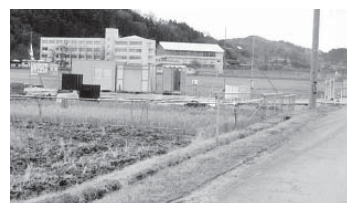
邑知中学校周辺工事中
