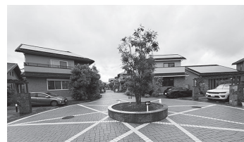
液状化対策工事後の新住宅団地・久喜市
