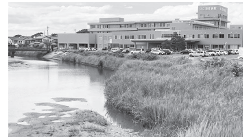
市街地河川の堆積土砂と雑草の状況
