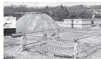
地下水位低下工法の実証実験(白鷺公園)
