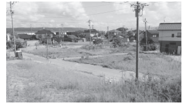
液状化による被害が大きい桜ヶ丘地区
