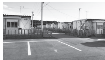
建設型応急住宅（眉丈団地）
