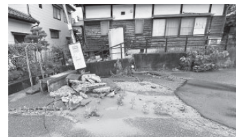
発災以来対策が進まない液状化地域
