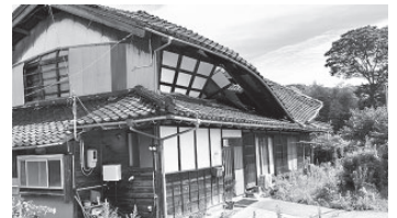
地震被害で倒壊が進む住家
