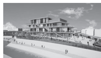
防災拠点として機能するLAKUNAはくい
