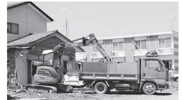
解体される被災住宅
