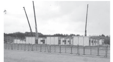
眉丈台地で建設中の仮設住宅
