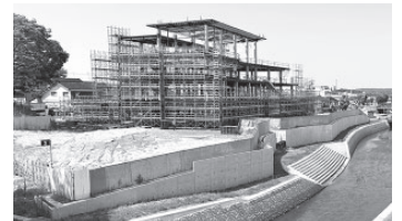
にぎわい拠点として建設中の、ラクナはくい
