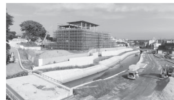
「Lakuna はくい」進む周辺整備
