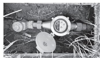
漏水調査で、水道メーターの状況確認
