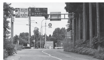
国道415号県境部分
