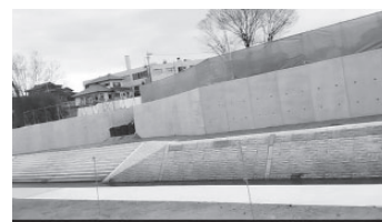
駅前周辺賑わい交流拠点の擁壁
