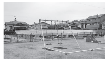
危険なフェンス これでは危ない
