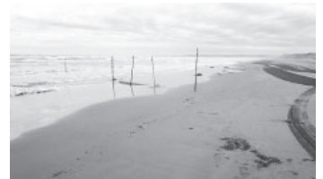
千里浜の既存排水管の流末状況
