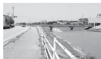
融雪装置が必要な羽咋病院周辺道路
