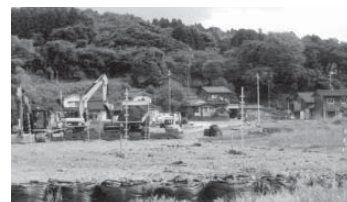
県道盛土工事(飯山町地内)
