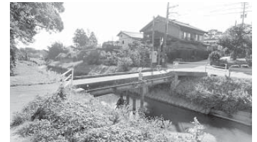
兵庫町の山出橋
