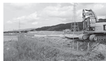
国道159号羽咋道路工事状況
