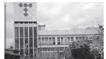
廃墟のトーカマート
