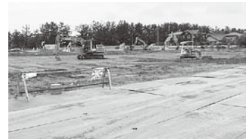
道の駅「のと千里浜」造成工事
