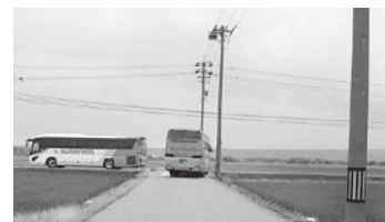
幅員の狭い市道羽昨202号線
