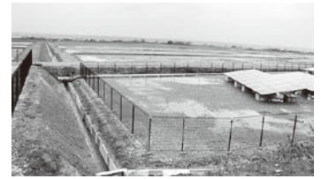
滝地区ほ場整備
