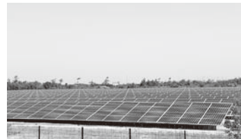
太陽光パネル
