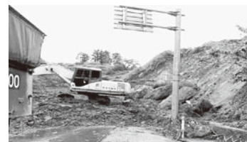
眉丈トンネル復旧工事
