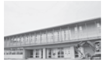
羽咋中学校外構工事
