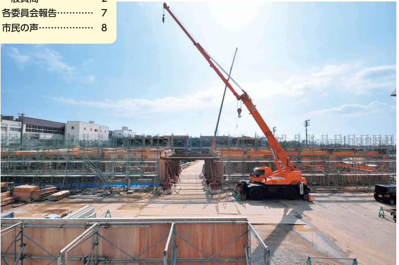
改築中の羽咋中学校
