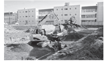
建設中の羽咋中学校
