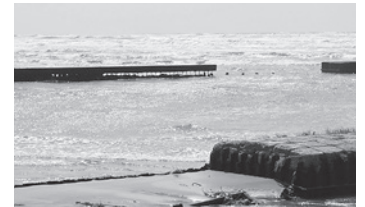
羽咋川河口の矢板腐食
