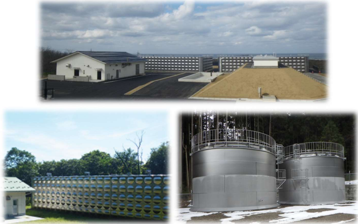
【写真】 上：南部配水場、左：北部配水池、右：東部配水池（建設中）
