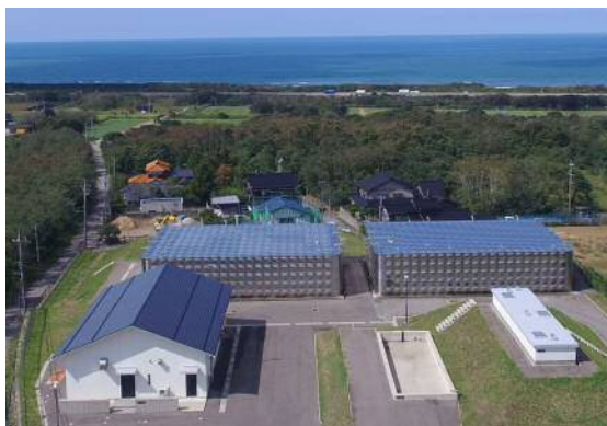
南部配水場 平成 27 年竣工
