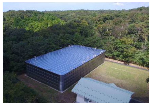
北部配水池 平成 19 年竣工
