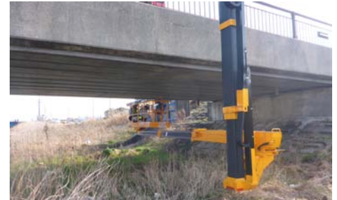
定期点検状況
