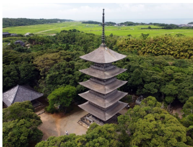
国重文建造物 妙成寺五重塔
