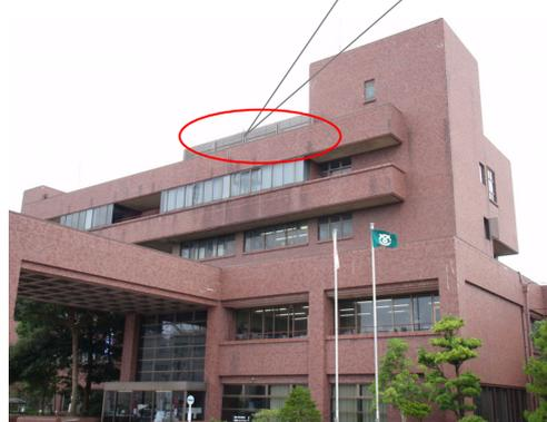
屋上の建築設備を外壁と同じ色彩の部分的なルーバーで遮へいすることにより、建物と一体的に見せています。
