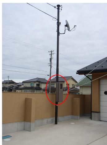
引込柱に外壁と同色系のメーターボックスを取り付けています。
